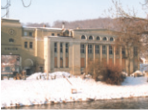
1. Geschäftsgebäude „WEMA UNION“ Im ausgebauten Dachboden der WEMA Union bezieht die AWG ihr erstes Domizil.
