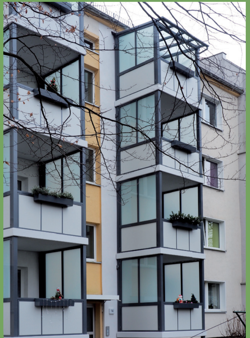
neue Balkone an der Arminiusstraße 10-14
